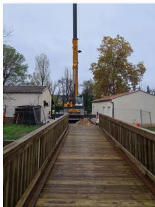
Pose de la passerelle entre l'ancien stade et le skatepark - novembre 2022
