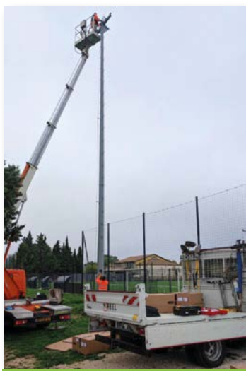
Rénovation de l'éclairage du stade - Octobre 2022
