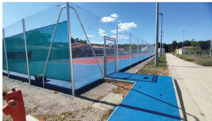
Réfection des courts de tennis - Juin 2022
