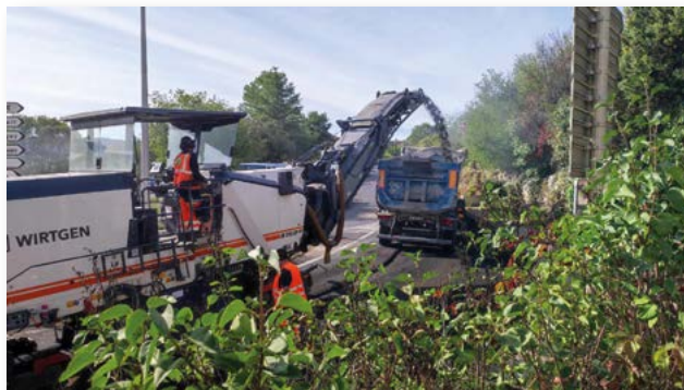
Travaux de voirie par le Département
